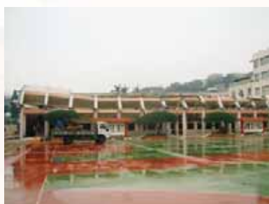
說明1：老舊校舍拆除（勵學樓）
