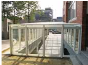
說明2：行政大樓車道整修
